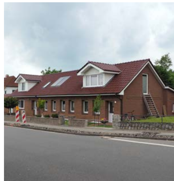
Bebaute Baulücke in Dannewerk (Foto: Merlin Michaelis, BUND SH)
