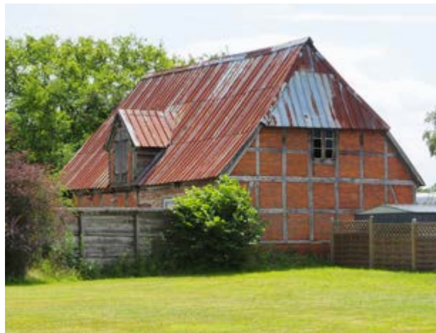
Wenn alte Bausubstanz nicht mehr nachgefragt wird und Sanierungsarbeiten unattraktiv werden, kann sich ein Abbruch und Neubau lohnen. (Foto: Merlin Michaelis, BUND SH)
