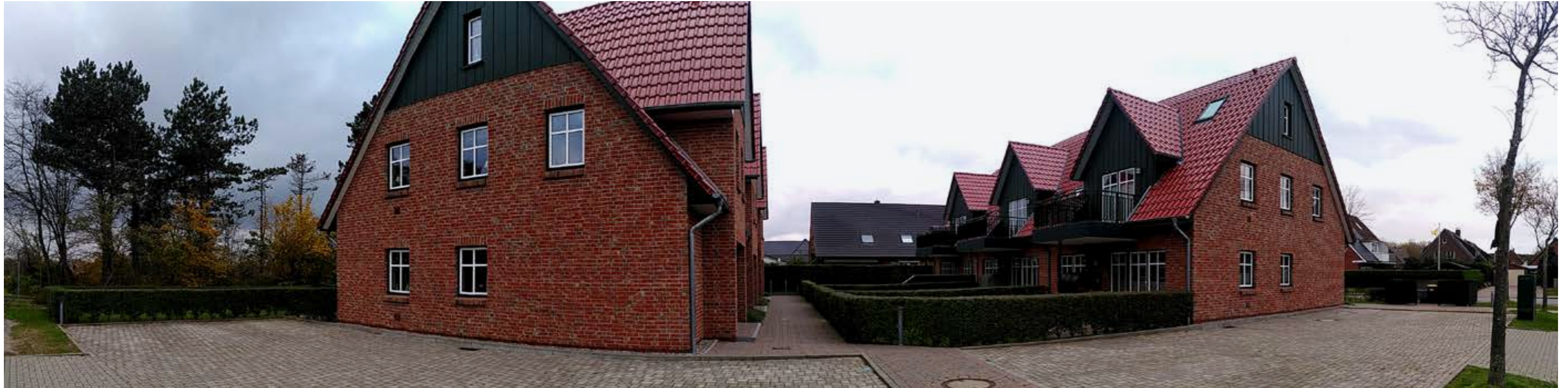
Besonders an den Küsten und auf den Inseln entstehen vermehrt Ferienwohnungen. Das bedeutet nicht nur mehr Flächenverbrauch, sondern verschärft auch den dort bereits angespannten Bodenmarkt für Einheimische. (Foto: Merlin Michaelis, BUND SH)
